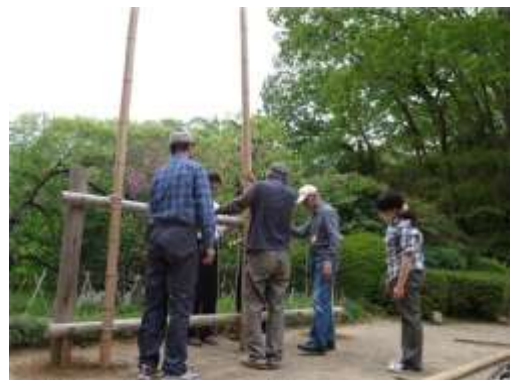
武者幟の竿立て作業
